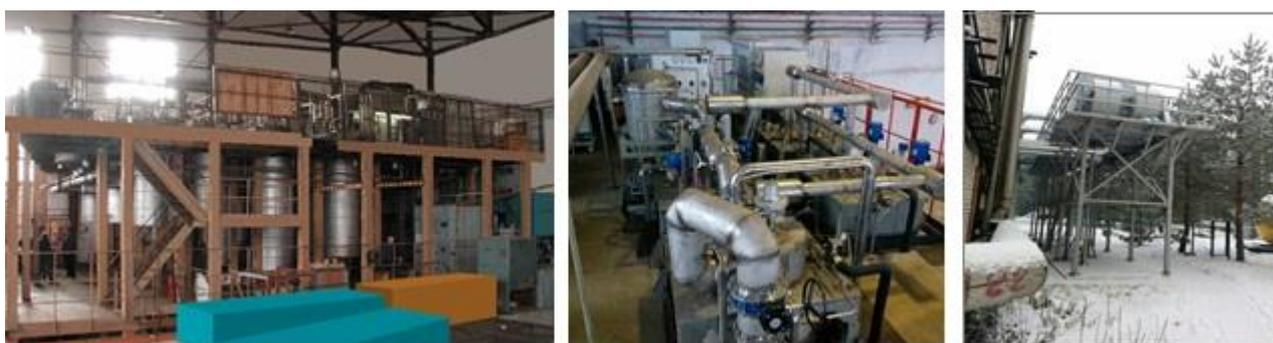
Рис. 51. Гелиевые рефрижераторы КГУ-1600/4,5 (слева), ожижитель гелия ОГ-1000 (в середине) водооборотная система охлаждения компрессорной станции (справа).
