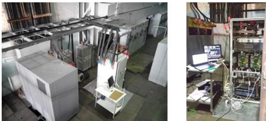
Рис. 44. Источник тока ИП 2500-280: общий вид (слева) и шкаф управления (справа).
