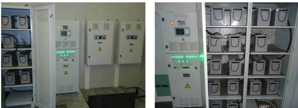
Рис. 55. Оборудование для реконструкции системы оперативного тока.
