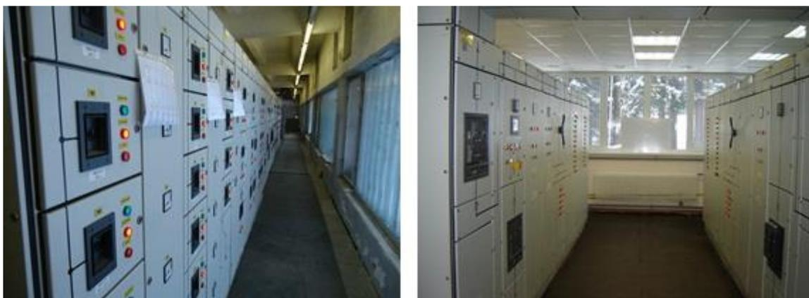
Рис. 54. Реконструированные РЩ корпусов 205 (слева) и 217 (справа).
