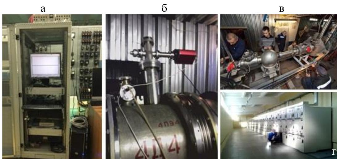
Рис. 5. Модернизированные система питания и защиты магнитов (а), один из элементов вакуумной системы (б), система диагностики (в) и электроснабжения (г) Нуклотрона.
