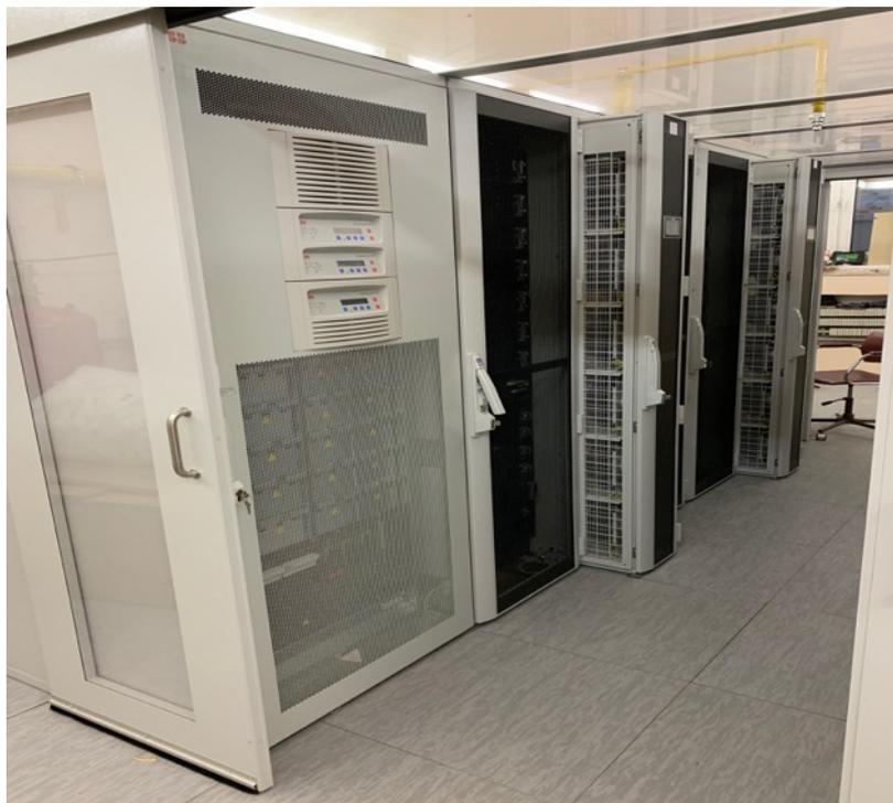
*Рис. 2.4.4.1. Реализованный off-line кластер ЛФВЭ.*
