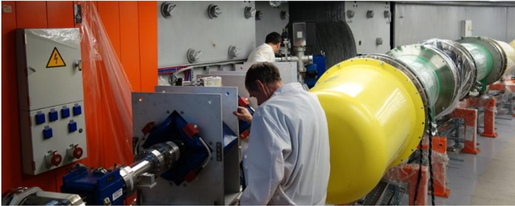
*Рис. 2.1.2.15. Элементы канала транспортировки пучка из НИЛАС в Бустер в процессе монтажа.*
