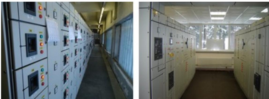
*Рис. 2.3.7.4. Реконструированные РЩ корпусов №205 (слева) и №217 (справа).*
