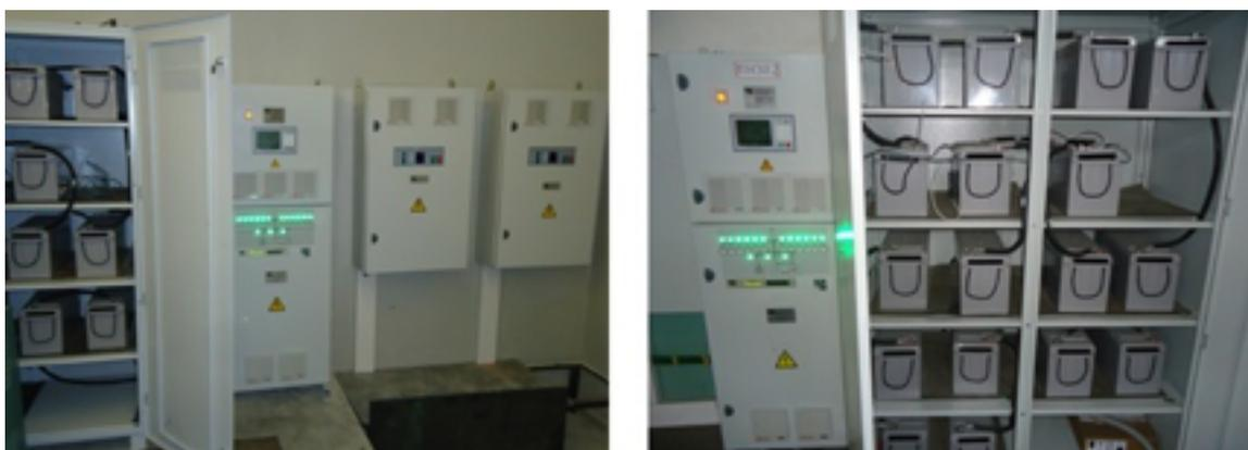
*Рис. 2.3.7.3. Оборудование для реконструкции системы оперативного тока.*
