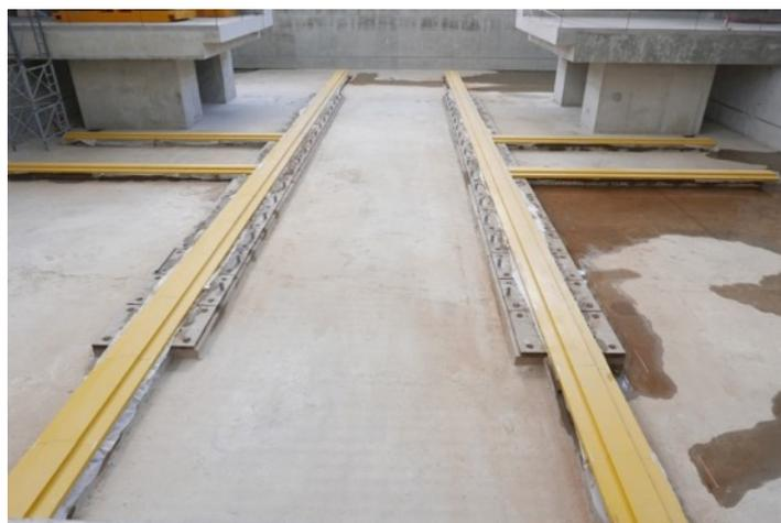
*Рис. 2.2.1.10. Рельсовые пути в прямке павильона МРД; рабочие поверхности закрыты кожухами.*
