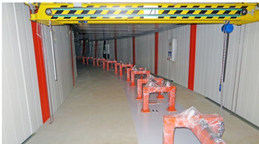
Рис. 6. Тоннель Бустера, подготовленный к размещению элементов магнитно-криостатной системы.
