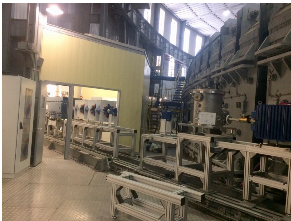
Рис. 56. Строящийся канал транспортировки пучка из NPLAc в Бустер, где будет установлена СОКИТ - станция тестирования микросхем при декапсуляции их корпуса и секция транспортировки пучка к ней.
