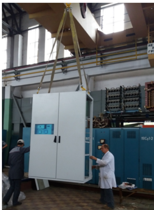
Рис. 9. Ключ эвакуации энергии системы защиты Бустера, машинный зал корпуса 1А.
