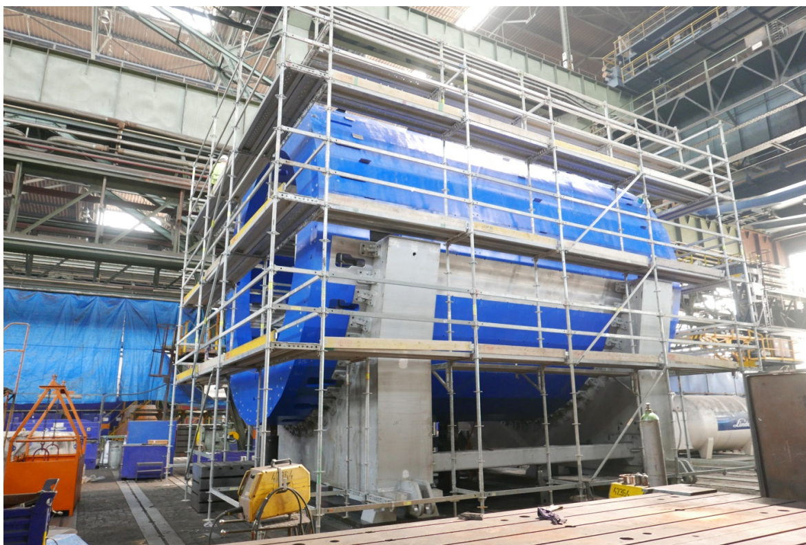
Рис. 16. Магнитопровод в сборе заводе в Витковице (Чехия).
